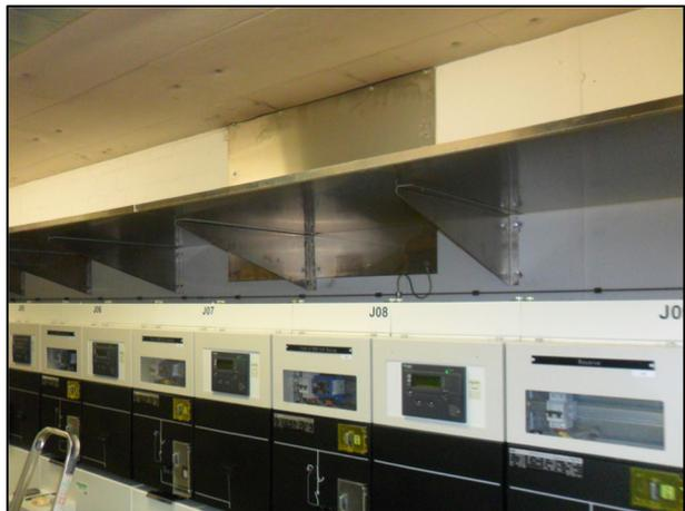
TS Industriehalle: Abschirmung von Transformatoren und Mittelspannungsanlage gemäss NISV-Berechnung.
