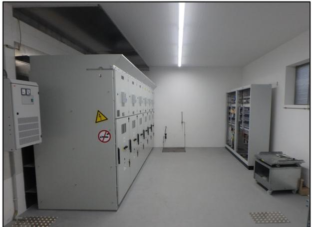
TS Bahnhofstrasse: Abschirmung von Mittelspannungsanlage gemäss NISV-Berechnung (siehe oben).
